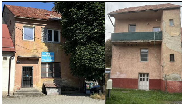
budova č. s. 41 pôvodný stav
