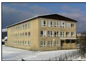
ZŠ pred rekonštrukciou
